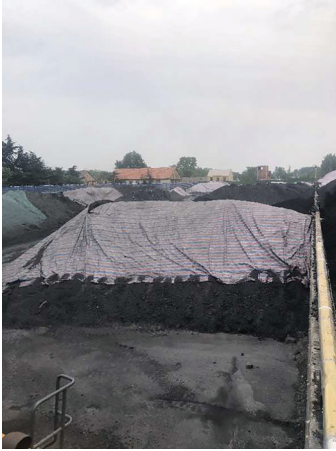
内部升级工程前期准备
